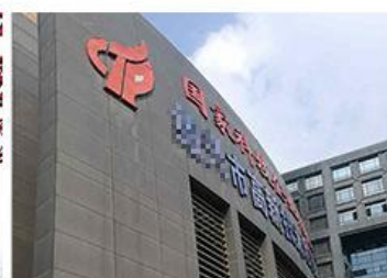
铝塑板外墙翻新
